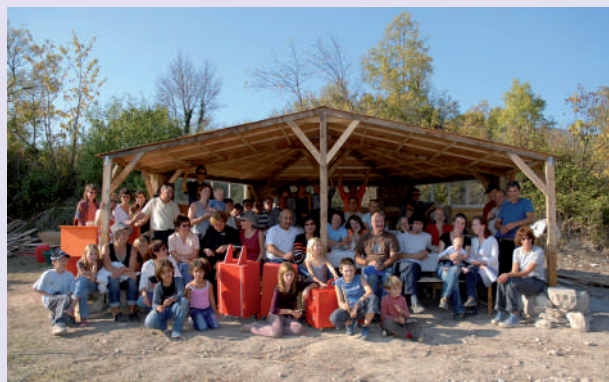
Avec les médiateurs, les Cobonnais ont eux-mêmes construit le «Kiosque», qui deviendra leur lieu de pique-nique et de retrouvailles favori.
